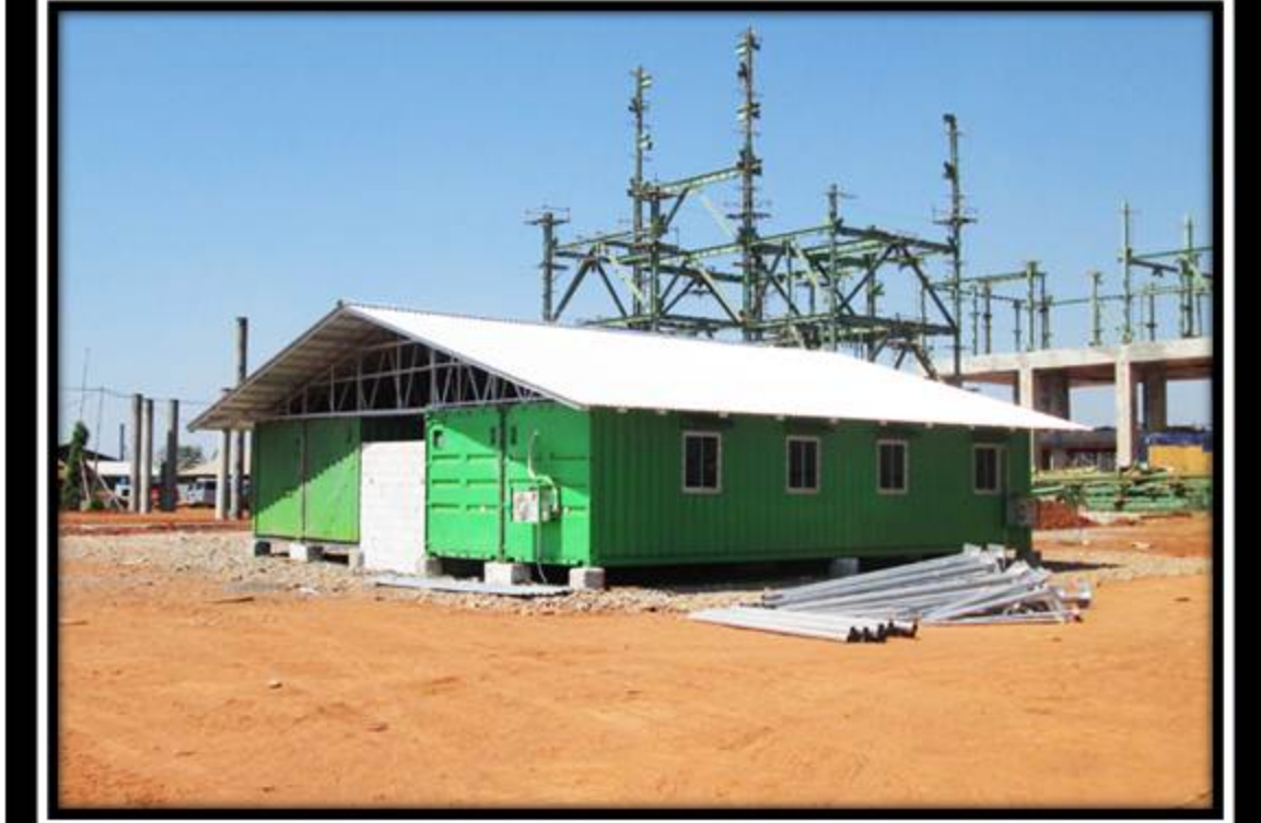
Project ke 3 Gudang fasilitas PT. Cikarang Litrindo produsen listrik di Babelan Bekasi
