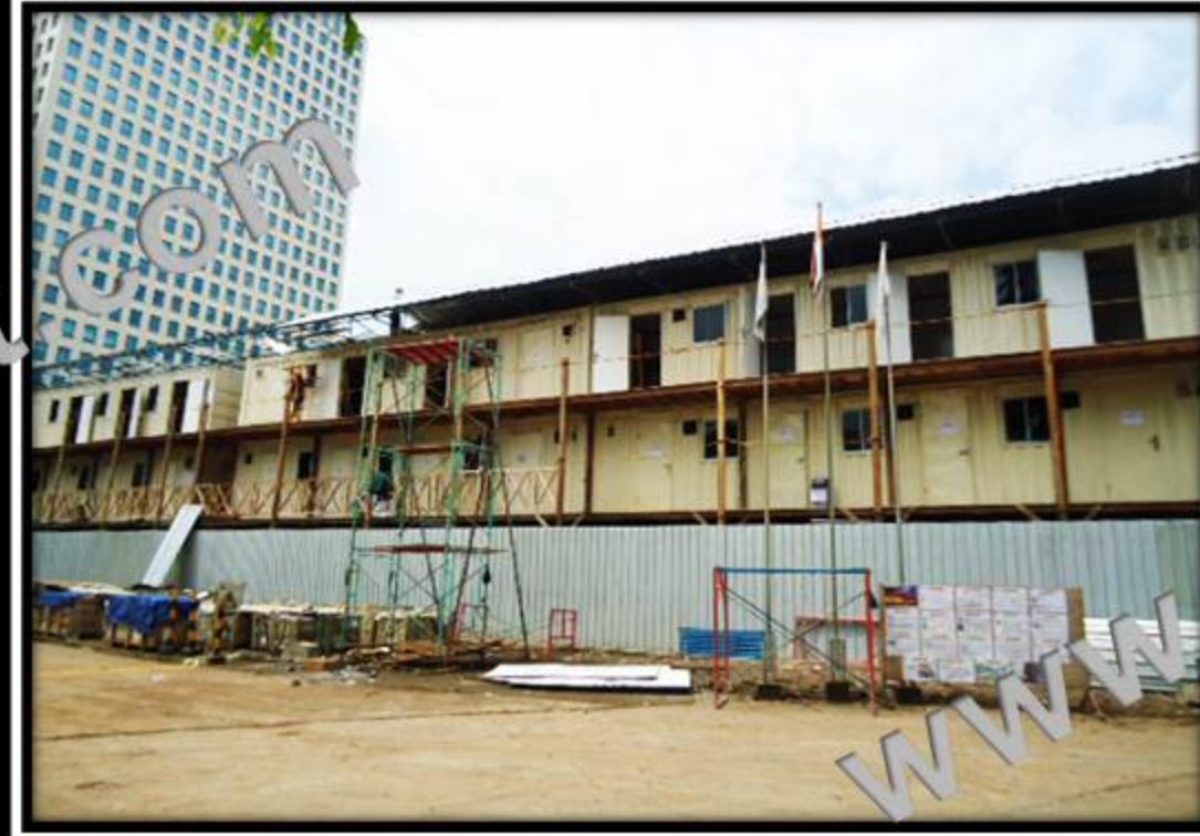
Project Mess di PT. Kajima Indonesia Senayan dalam pembangunan hotel
