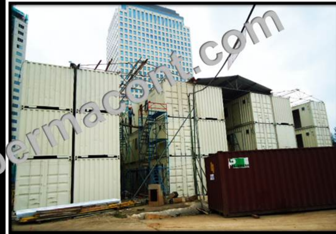
Proses instalasi container mess karyawan di PT. Kajima Senayan-Jakarta
